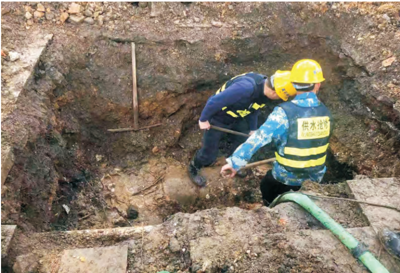
管网抢修人员春节期间抓紧抢修进度
